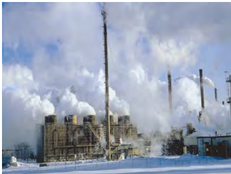
Рис. 182. Химически опасный объект
