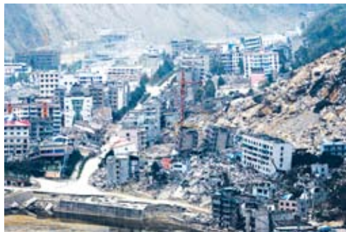
Рис. 12. Последствия сильного Сычуаньского землетрясения в Китае (2008)
